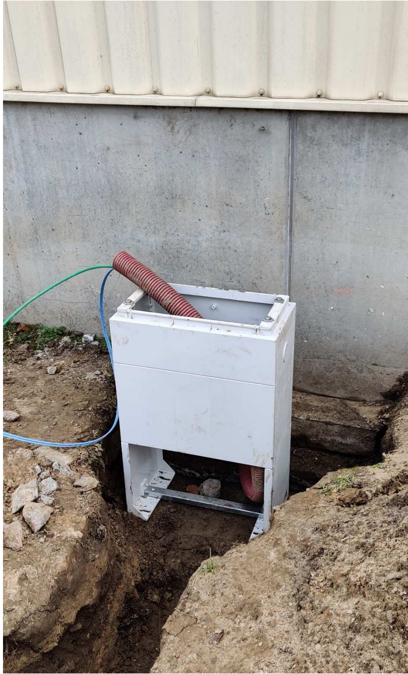
Milan leerling 7 de Industriële elektriciteit (elektrische leidingen 0.8m diep)
